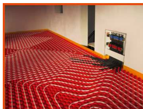
PANNELLI RADIANTI A PAVIMENTO
